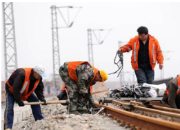
黄韩侯铁路侯西段电气化复线施工
