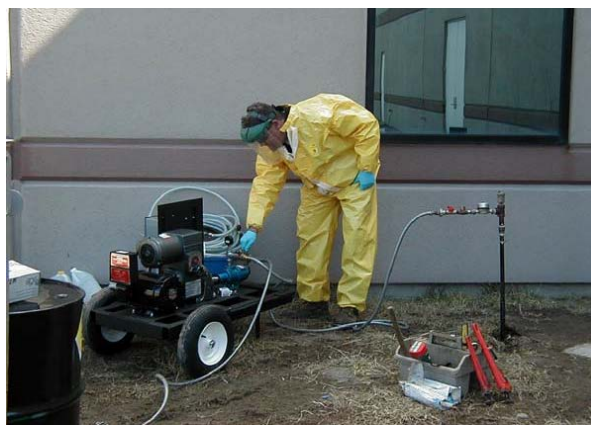
图 B.2 原位化学氧化(注入修复)现场图
